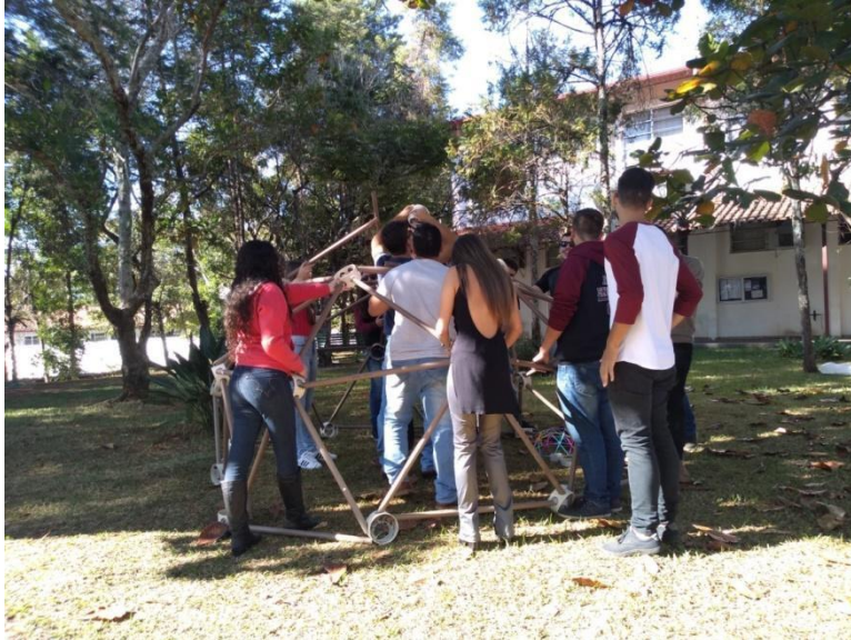
Figura 4 – Início da montagem do modelo em tamanho real
